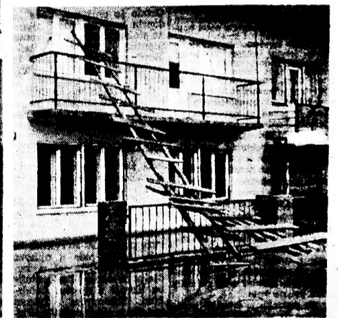
Improvizirani viseći mostovi na Fallerovom šetalištu
